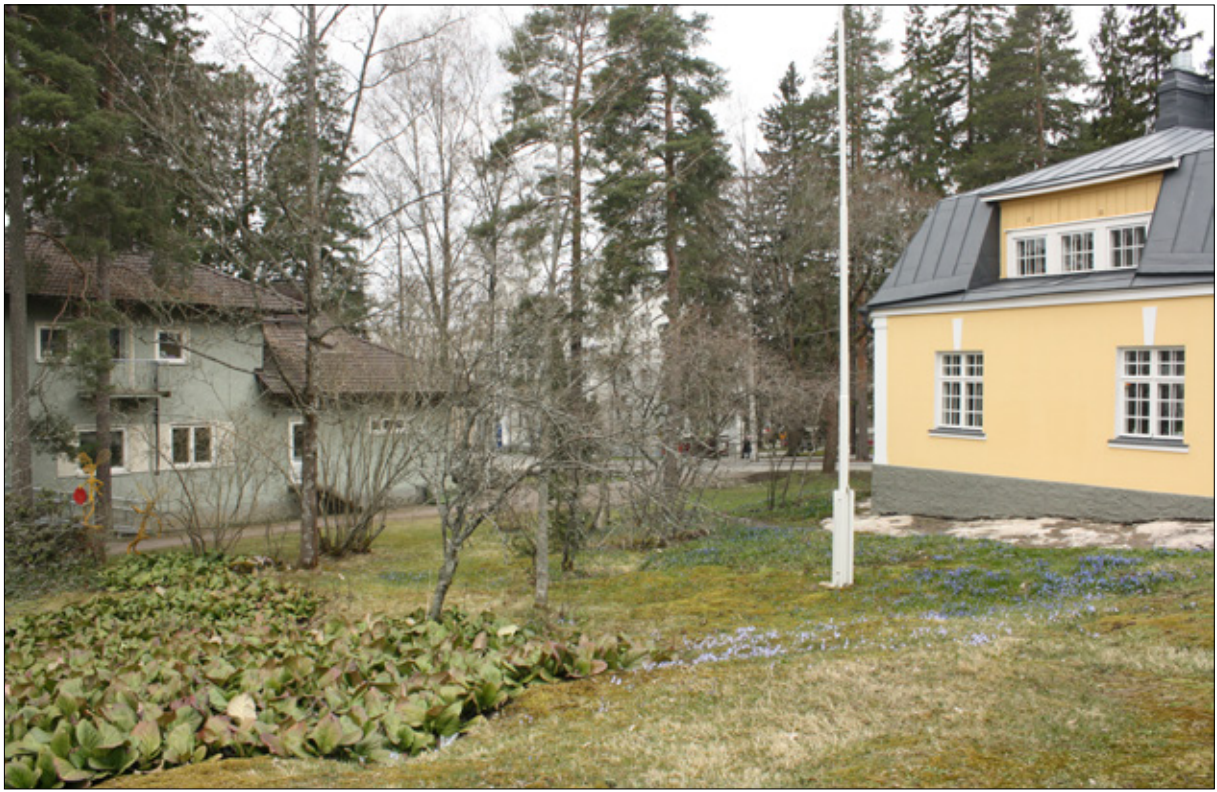
Vasemmalla Kauppalanlääkäriin talo ja oikealla Westermarckin konttorirakennus. Näkymä Hyvinvointikam- puksen suunnasta.
